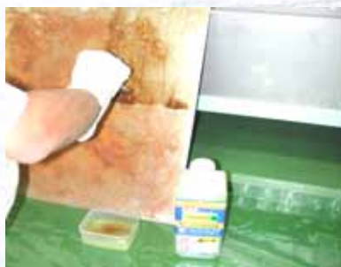
サビ取り施工中
